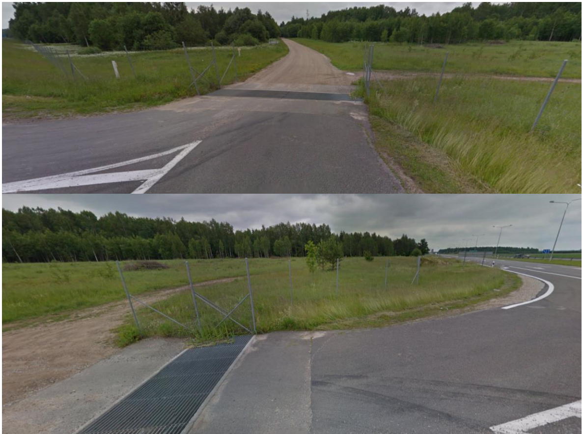
20 pav. Apsauginės metalinės grotos nuo apsaugai nuo laukinių gyvūnų patekimo į kelio važiuojamąją dalį
